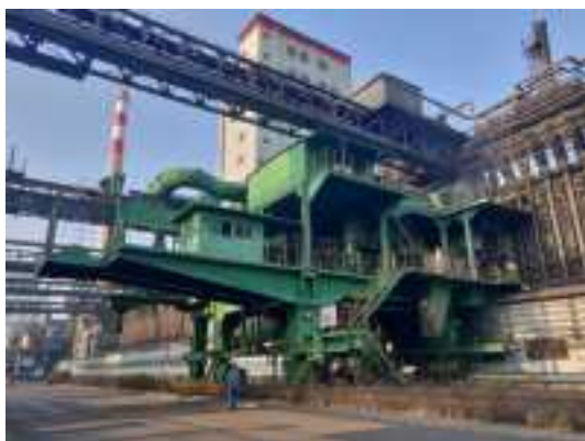
焦炉，周边地面均硬化，但部分区域存在裂缝
