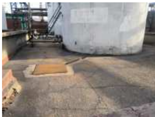
轻苯罐区，设有围堰，地面存在裂缝
