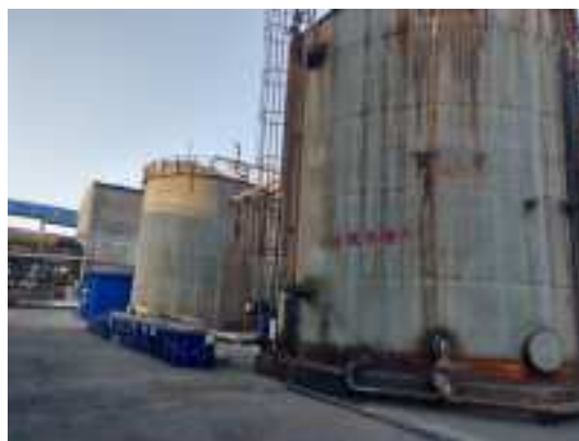
焦油氨水分离槽，四周地面均进行硬化，但部分区域存在裂缝
